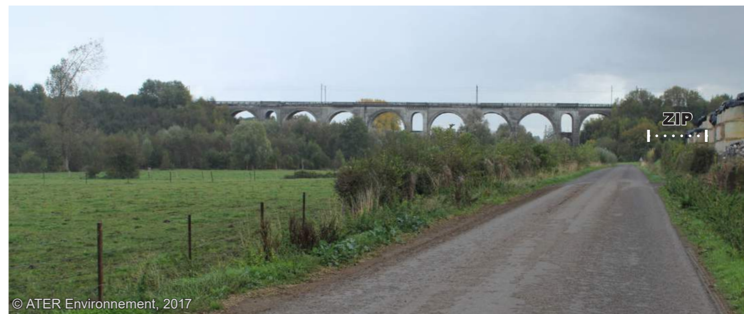
Fig. 141 : Viaduc entre Le Cateau Cambrésis et St-Benin
